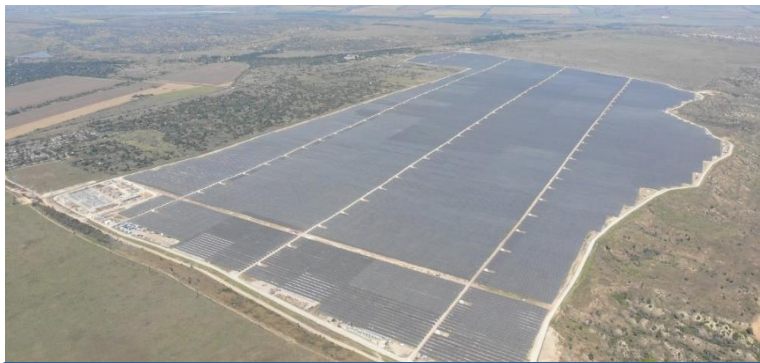
Покровська СЕС, 240МВт
